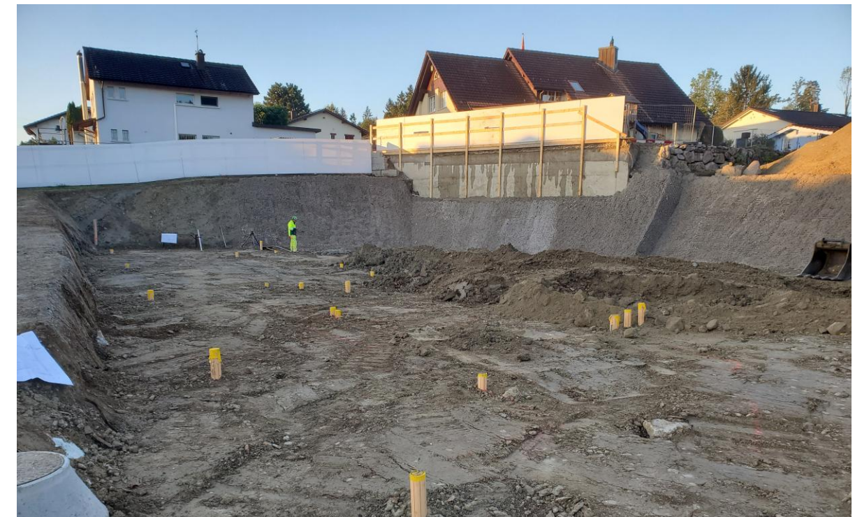
Aushub mit geböschter Baugrube, lokaler Baugrubensicherung und Foundation mit Magerbetontatzen
