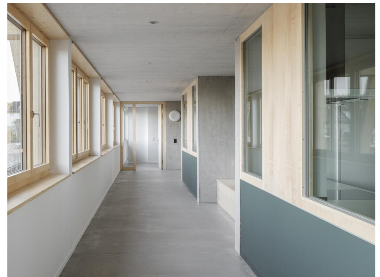
Hybridbauweise mit Betondecken und tragender Holzfassade
